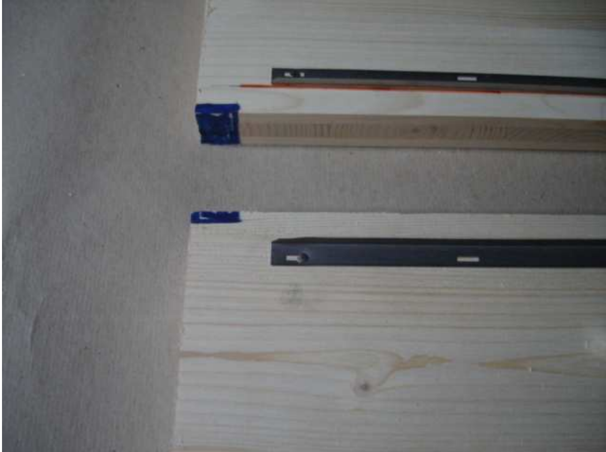
Aussparung für Aluschiene
